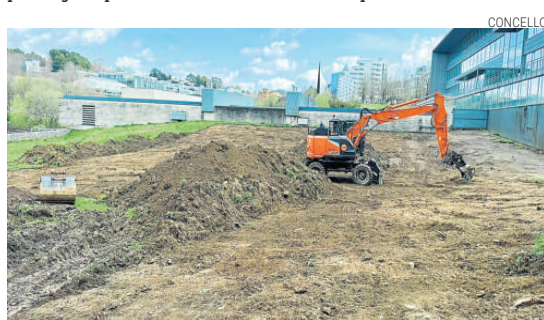
Inicio da actuación nas inmediacións do Hospital
